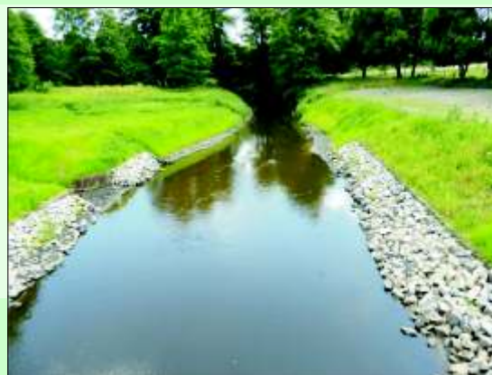
Widok z mostu w Leboszowicach
