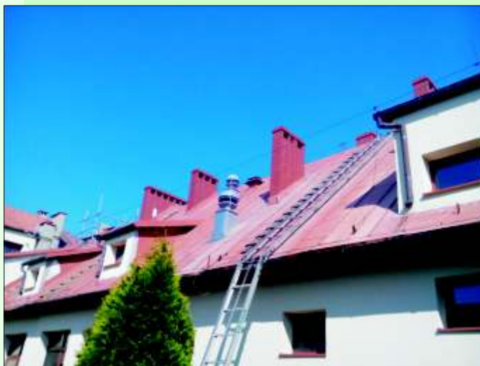
Remont dachu szkół w Żernicy
