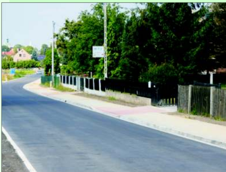
Dolna Wieś w Pilchowicach - inwestycja Powiatu Gliwickiego
